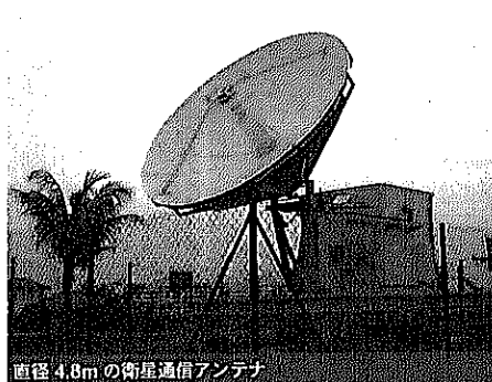
直径4.8mの衛星通信アンテナ
