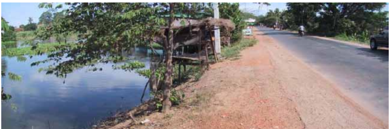
Sta. 12+000 道路北側の湿地帯 洪水時には同湿地帯にも水が流入し、一気に流越が起るため、一定の高さが必要となる
