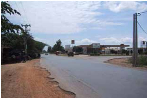
Sta. 6+800 タカベール工場への道路との交差点部 見通しが悪いため、安全性の確保がない
