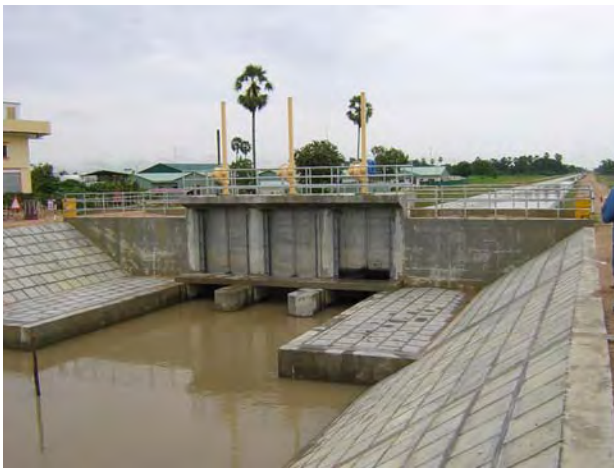
写真2 カンダルストウン地区幹線水路 取水口
