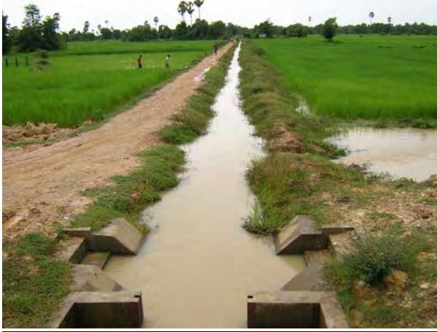
写真 4 カンダルストウン地区 3 次水路 (施工後)
