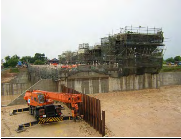
写真1 カンダルストウン地区頭首工 (日本国の無償資金協力により 建設中)
