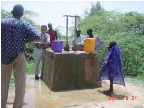
ティラベリ 県アユルコミュンフィルゲンハウサ村の給水施設、1980年代に建設され排水路などが無い古い構造となっており、2連のベルニエポンプが取り付けられている
