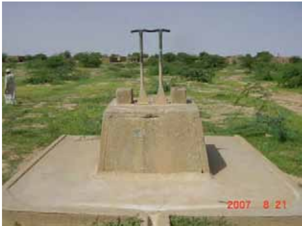
ティラベリ県ガブ村の廃棄井戸、1980年代に建設された揚水量の多い井戸で2連になっているが、すぐに枯れたという。掘削深度が十分でないなどの技術的問題があったと想定される
