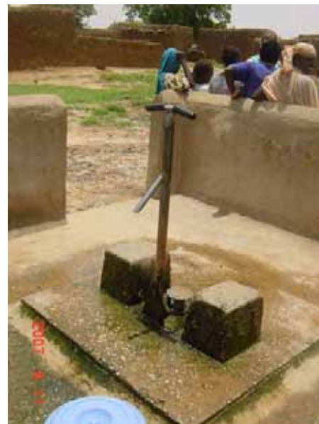
テラ県フィラウコイラ村に設置されているベルニエ足踏みポンプ、1984 年に FED が建設、23 年間使い続けられている
