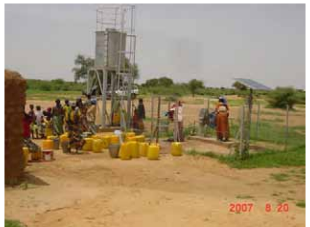
ティラベリ県ドウコウーサウラ村に Plan Niger (NGO) と Belko (井戸掘削会社) が設置した簡易ソーラー給水施設、ハンドルを上下させるクランクが故障しており、人力で汲んでいる
