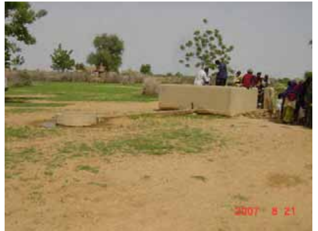
ティラベリ 県フェリエ村の給水施設、1990年代に建設されたもので、ティラベリ州では壁が方形となっているタイプの給水施設が多いとのこと
