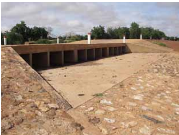
テラ県内の国道4号線のワジを横断する橋梁部、リグの走行には問題無い
