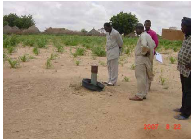
ティラベリ 州コロ県カルマコミューン ディンキ村で 2002 年に AFD プロジェクトで掘削された失敗井戸、上部の砂層部分が崩壊した、泥水管理やケーシングプログラムの不備などの技術的な未熟さが招いたと判断される。掘削業者はその当時大手であった Forafrique である。
