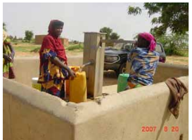
ティラベリ 県フェリエ村の給水施設に取り付けられたカルディアポンプ、ベルニエポンプと同様にティラベリ州で一般的に普及している人カポンプ
