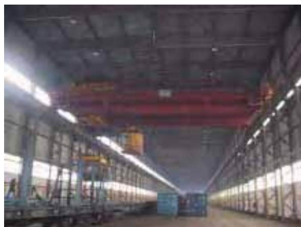
(Электрический мобильный кран в ПМ № 4)
