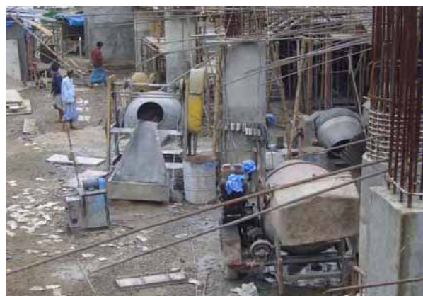
建設現場：PC社
