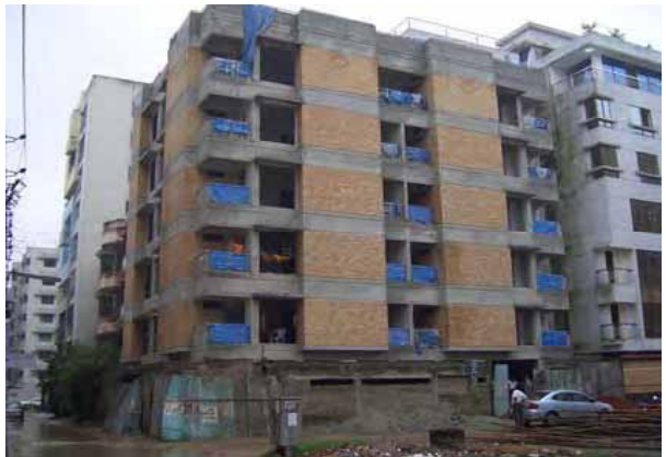
建設現場：HR社
