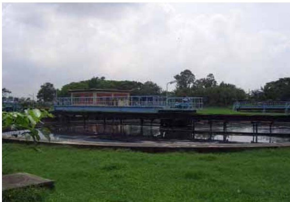
パグラ汚水処理場（第一沈殿槽）
