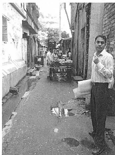
事業対象候補地：配管工事対象となる道路
