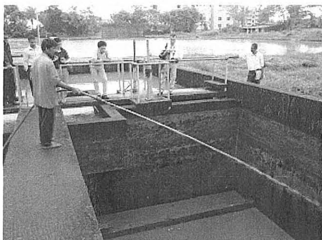
カルルガット浄水場
