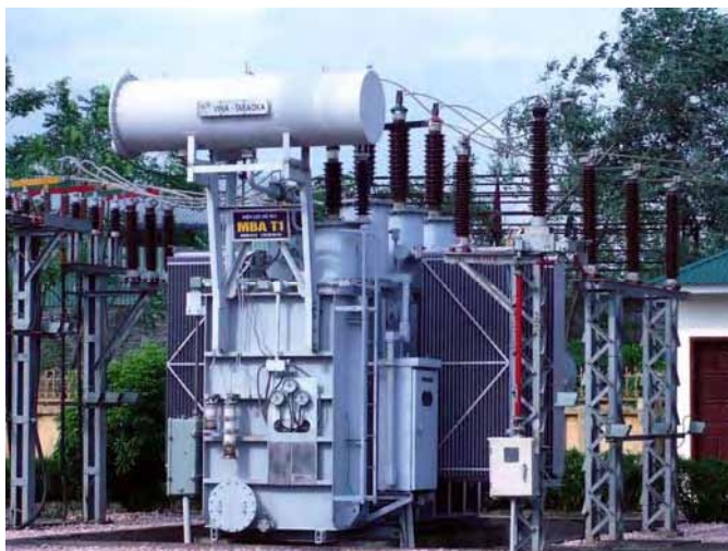
Nguồn: Đoàn nghiên cứu JICA Máy biến áp tạm (25MVA) của Trạm biến áp Khu CNC Hòa Lạc
