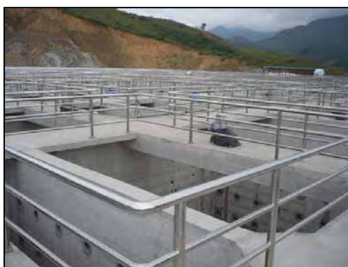
Nhà máy lọc nước
