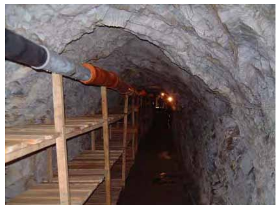
ダム建設時の試掘トンネルの整備状況
