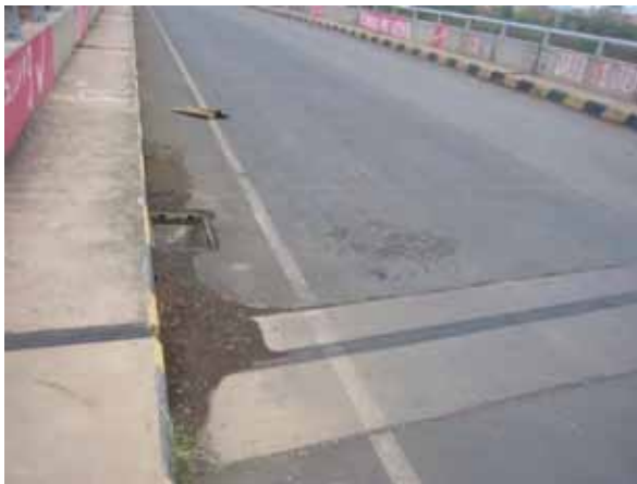
リオ・ネグロ橋。伸縮継手は健全
