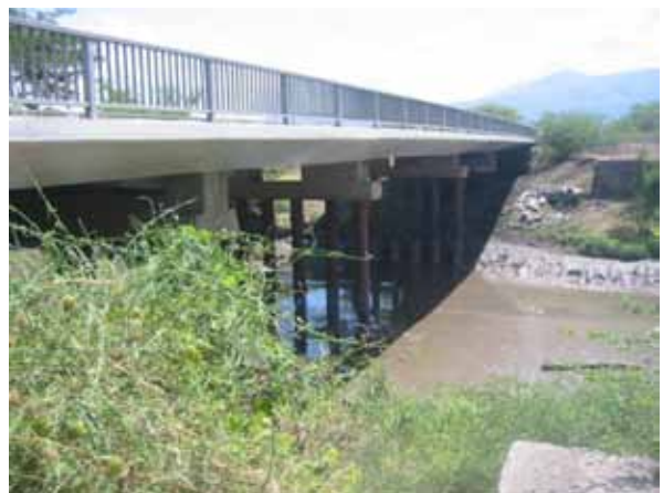
エステロ・リアル橋。橋台周り土留め工問題なし
