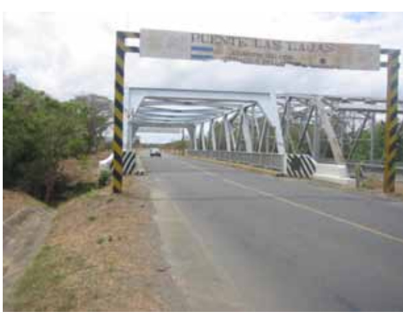
ラス・ラハス橋。防護柵は取替え済
