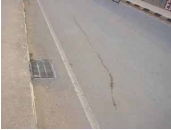
エル・ガジヨ橋、軽微な舗装の損傷
