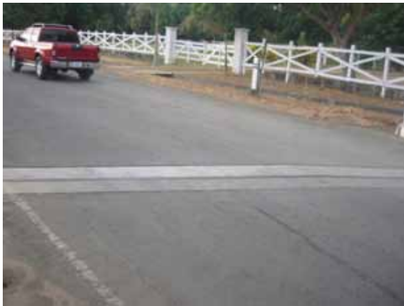
サン・ロレンソ橋。伸縮継ぎ手は健全
