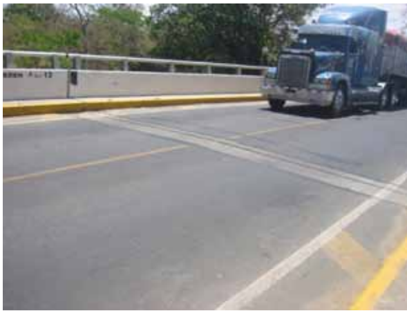
ヒル・ゴンザレス橋。伸縮継ぎ手は健全
