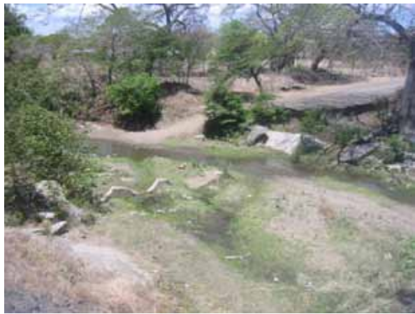
迂回路(RCパイプ)は撤去されていた。
