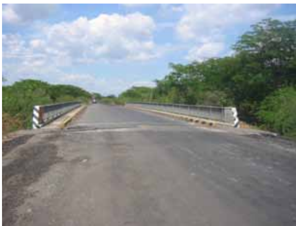
エステロ・リアル橋。舗装損傷あり
