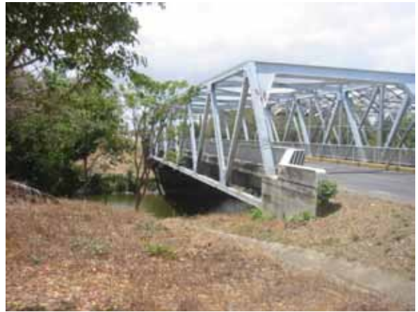
ラス・ラハス橋。タッチアップペイントが必要
