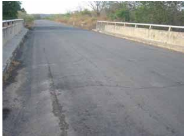
リオ・セコ橋。舗装の軽微な損傷
