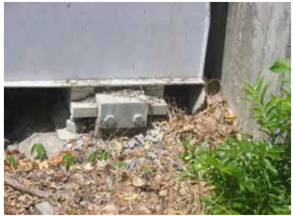
ラス・ラハス橋。支承周りの清掃が必要である。
