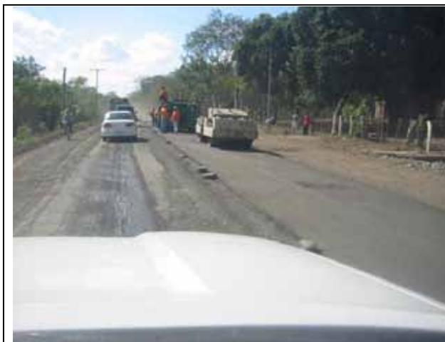
ナンダイメ付近、FOMAVによるAC舗装の切削再舗装
