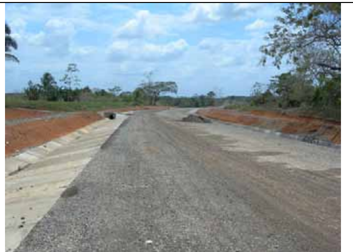
コスタリカ側は道路建設工事中で、今夏には完成の見込みとなっている。
