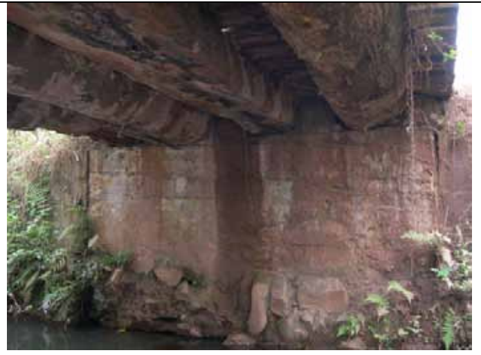
Quinto Lidia 橋の下部工（トレーラも走行するため、 直径 80cm もある丸太が使用されている）
