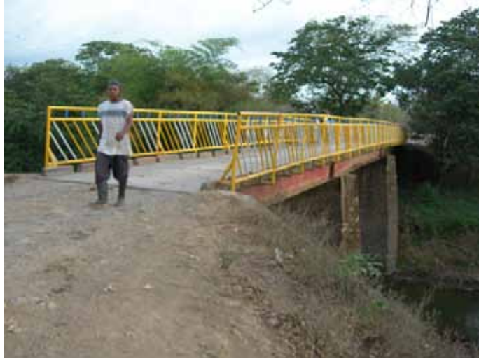
エルトゥーレ橋（幅員が狭いため、一方向しか車両は走行できない）
