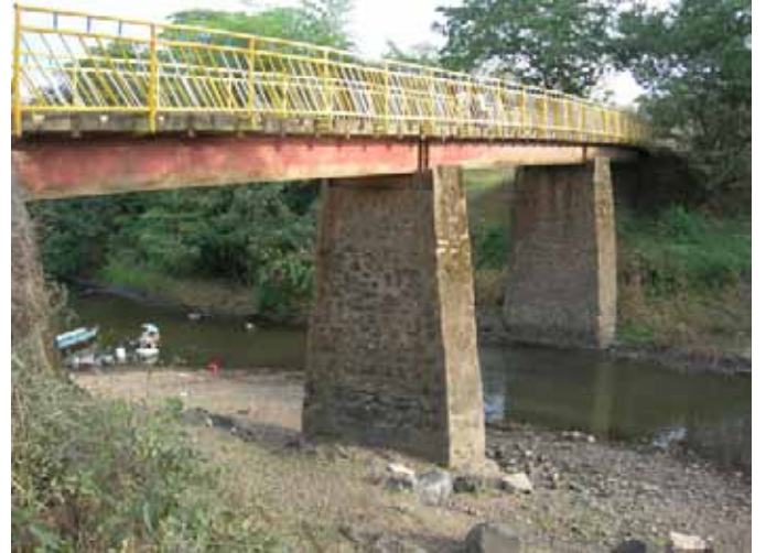
エルトゥーレ橋下部工（新しい橋は 500m ほど下流に建設される予定である）
