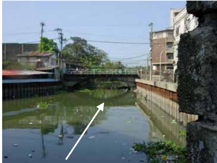
キアボ排水機場下流側水路 (2007年3月3日)
