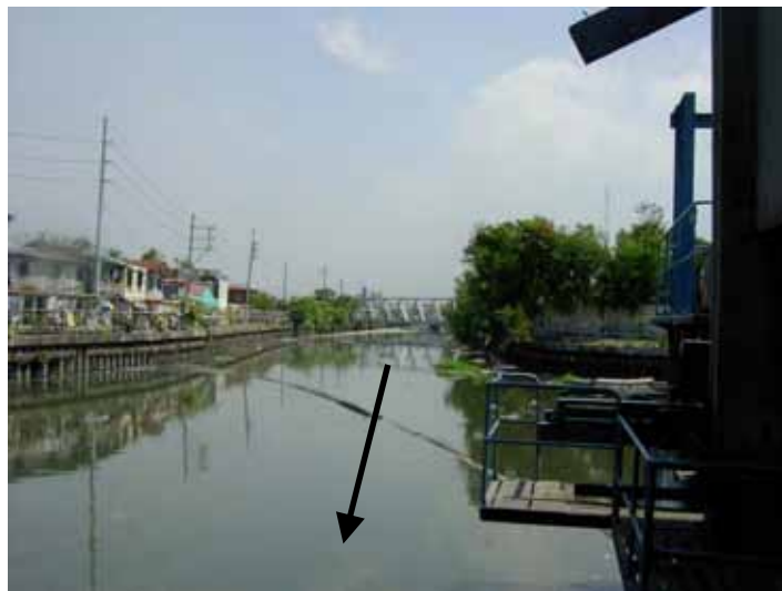
トリパ・デ・ガリナ排水機場流入水路 (2007年3月3日)
