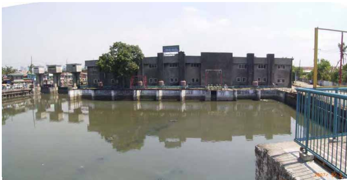
① 下流から見た排水機場全景（トリパ・デ・ガリナ排水機場）
