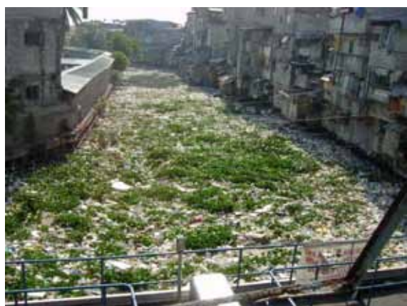
② 排水機場から見た上流水路。水路内には、浮き草やゴミが多く、水面を覆い尽くしている。（キアポ排水機場）
