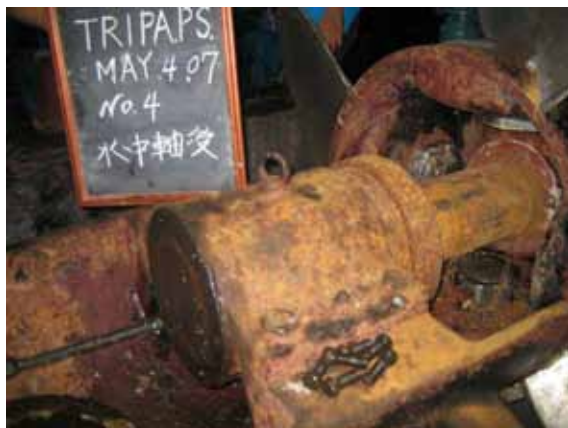
⑫ 水中軸受けは、交換部品がなく中古品を使用しており要交換。（トリパ・デ・ガリナ排水機場）
