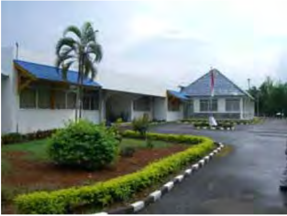
写真-12 既存 DIC の外観
