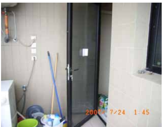
バルコニー出入口
