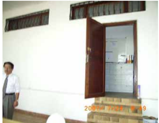
サロン出入口外扉 内側には鉄格子扉を取り付けている
