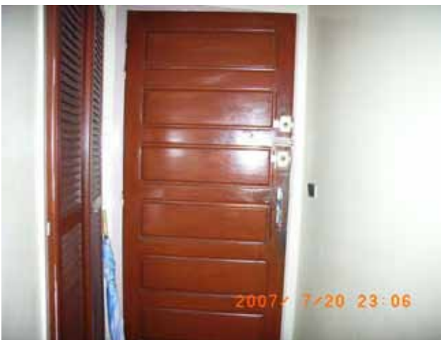
玄関扉の内側
