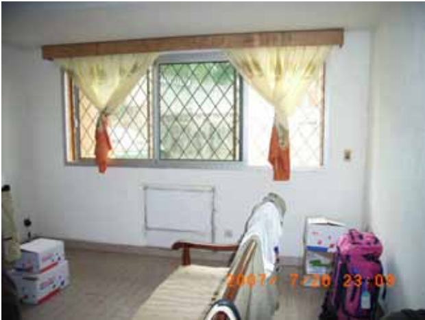
リビングの窓 外側に鉄格子を取り付けている。 窓下はエアコン取り外し箇所。
