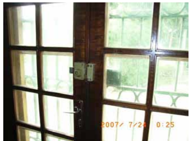
玄関扉の内側
