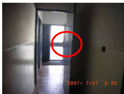
裏側のシリンダー錠 室内からは鍵を用いて開閉する
