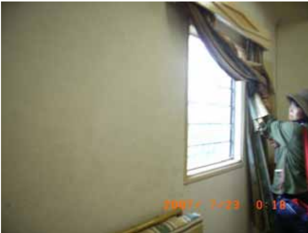
居間のルーバー式ガラス窓
