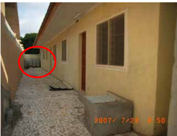
各室の玄関側 赤丸内鉄格子
