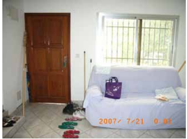
玄関扉とリビングの窓 錠前と窓との距離は約 68cm
