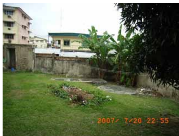
アパートの裏側の状況
