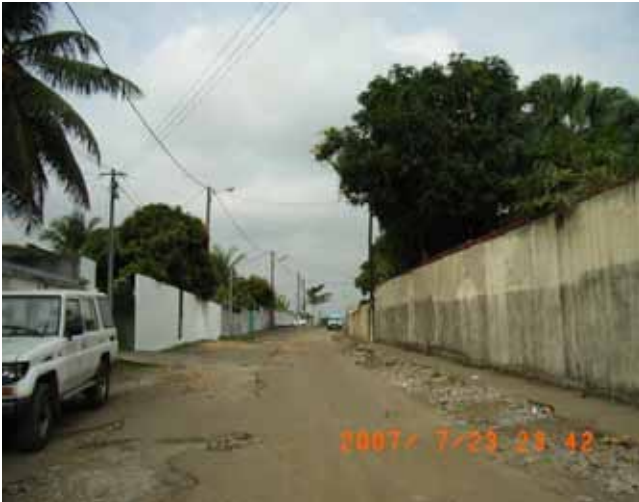
事務所前の通り 首都にもかかわらず道路は穴だらけ
