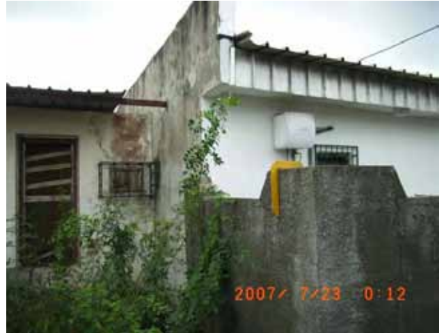
住居裏側 壁に接して廃屋がある
