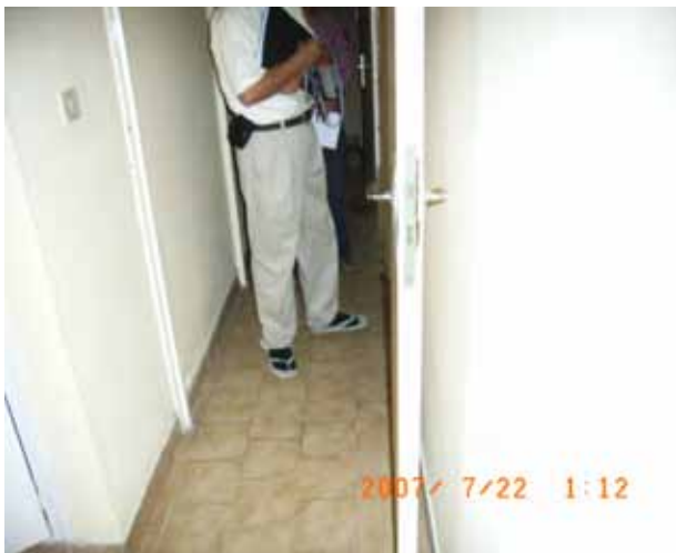
腐食している扉の錠前
