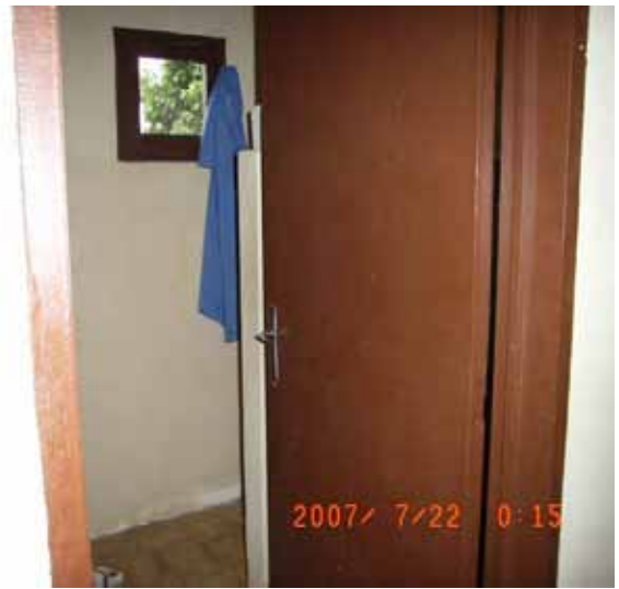
シャワー・トイレ室
