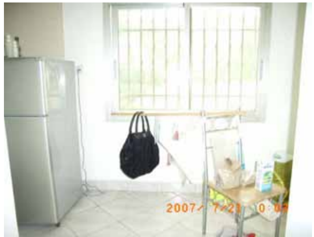
全ての窓には外側から鉄格子を取り付けている
