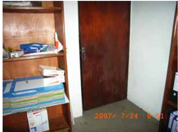
倉庫室扉 合板の扉棒鍵錠を取り付けている (図書室、男子寝室も同様)
