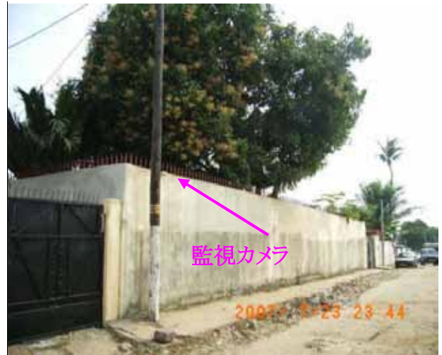
事務所の囲い堀 監視カメラ
