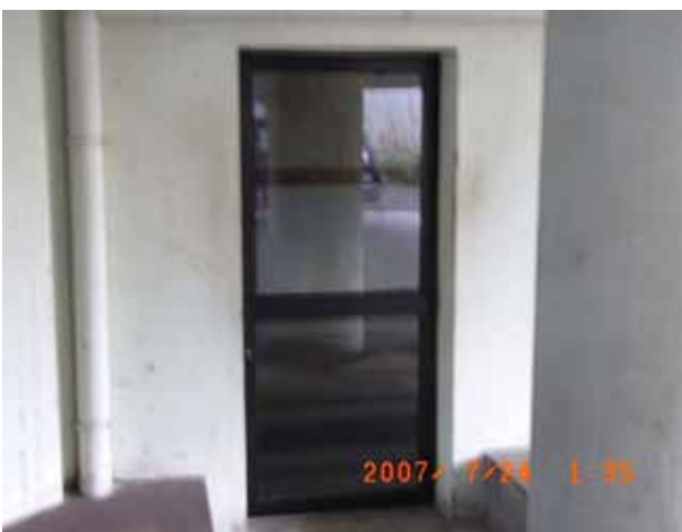
側面側の通用口
