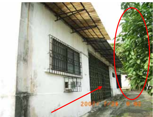
楢円内の目隠しの立木を伐採 矢印先はサロン入口
