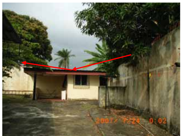
矢印のように隣家から洗濯室の屋根に下り 敷地内と、事務所の屋根から侵入懸念箇所
