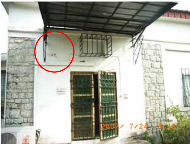
事務所入口 赤丸内監視カメラ
