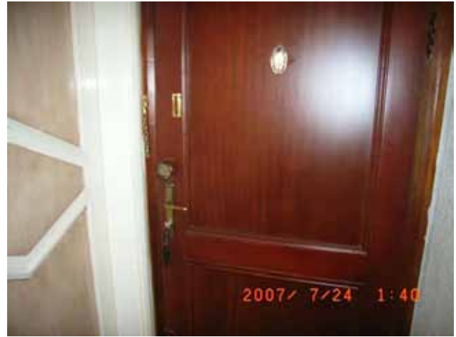
玄関扉の内側
