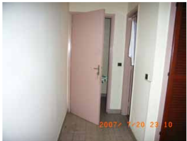
寝室の扉 合板扉、中央に棒鍵錠を取り付けている。
