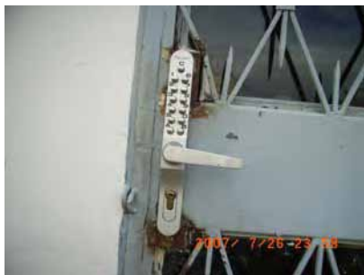
テンキー錠、電気は不要 両面シリンダー錠も併設
