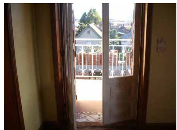
居間のテラス出入口扉 外側はシリンダー錠と差込錠付きの両開き板扉、内側は差込錠付きガラス扉
