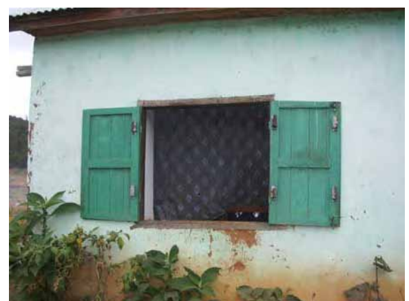
板窓を外に開いた状態
