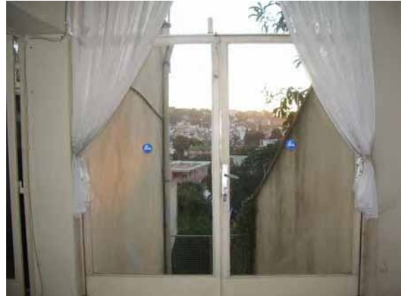
左同屋外出入口扉 シリンダー錠付き両開きガラス扉で 鉄格子扉は取り付けしていない。
