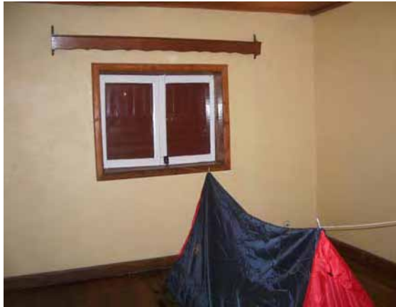
寝室の窓 外側が差込錠付き板窓、内側が差込錠付きガラス窓
