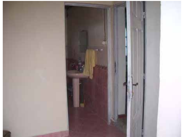
バス・トイレ室の出入口 扉は内開きシリンダー錠付き板扉
