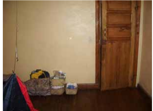
寝室出入口扉の内側 シリンダー錠を取り付けている。
