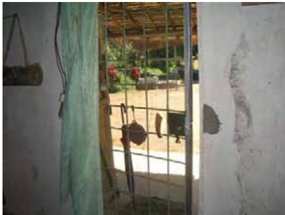
玄関扉の内側鉄格子扉
