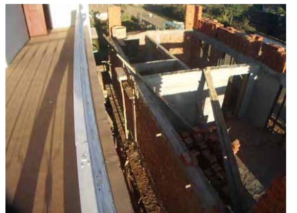
テラスと新築中の家屋の間隔 接近しており飛び移ることが出来る。
