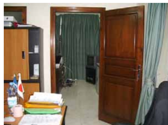
所長室出入口扉 シリンダー錠付き頑丈な板扉
