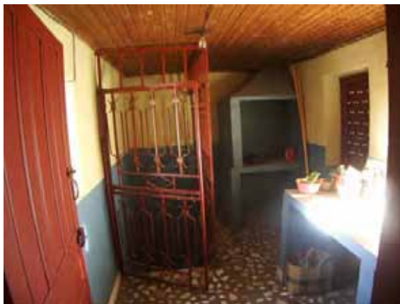
居室出入口前の扉付き鉄柵 階段を上ったところに取り付けている。 手前の扉は居室玄関のシリンダー錠付き扉
