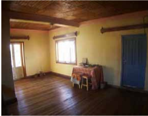
居間の窓とトイレ・シャワー室扉 窓は3枚式の外側が板窓、内側がガラス窓である。
