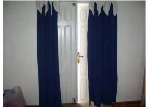
倉庫室扉の内側 両開き板扉のみで片側を差込錠で固定 している。
