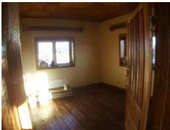
倉庫室 窓は外側に鉄格子付き
