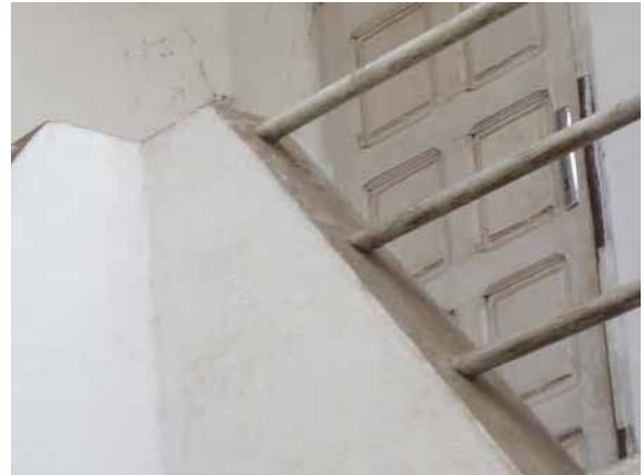
玄関の扉 棒鍵錠を取り付けている。
