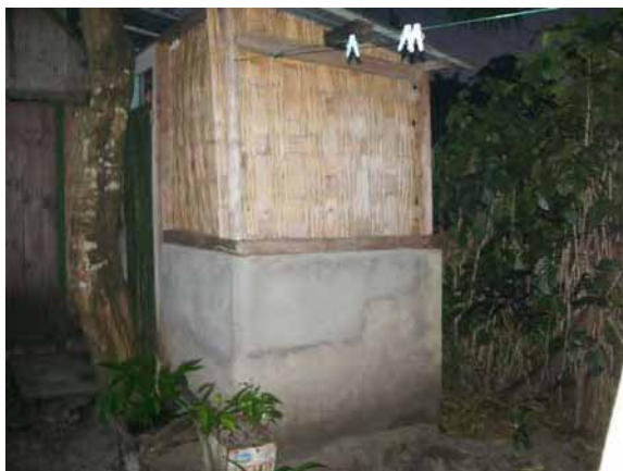
トイレ・シャワー小屋 出入口は左の緑に塗られた板部分
