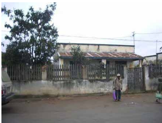
候補物件家屋の玄関側 右の板門戸は閉鎖している。
