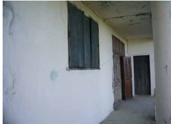
倉庫室の窓の外側
