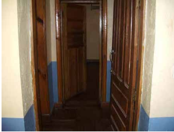
正面が寝室出入口の扉、左が居間の出入口
