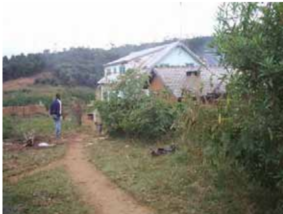
候補家屋 杭柵門から母屋に通じる通路
