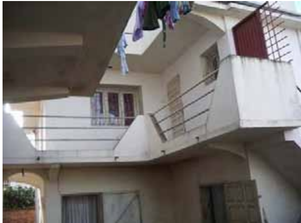
隊員住居の玄関側 階段を上ったところに鉄板扉を設置している。玄関扉は棒鍵錠付き板扉
