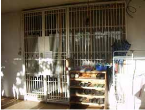
玄関 外側テンキ錠付き両開き鉄格子扉、内側シリンダー錠付き2枚ガラス引き戸
