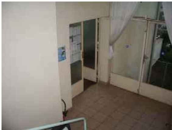
階段を下りた2階部分 正面のガラス扉は屋外への出入口扉 左の扉は職員執務室出入口扉
