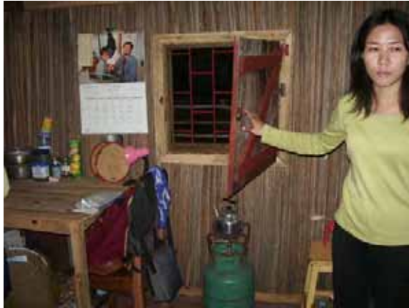
居間兼寢室の窓 内側閉錠付きの板窓、外側鉄格子付き
