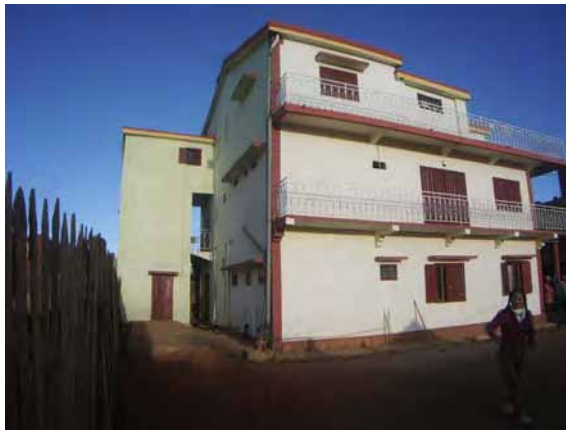
2階3階居住者用の玄関 3階に居住している隊員はでっぱり部分の玄関を使用している。
