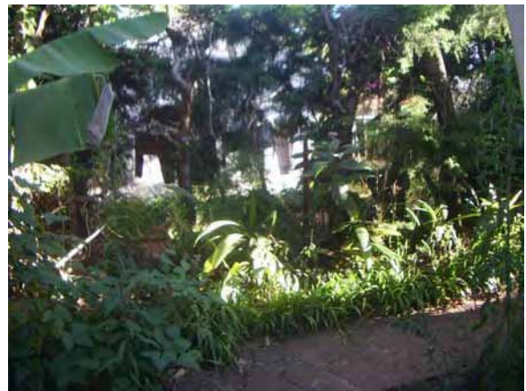
金網塀の破れている部分 玄関に向かって右側の隣家との境の 金網塀が破れている
