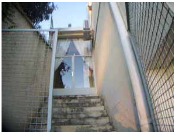
屋外から見た上記ガラス扉と高窓 手前に金網扉があるが乗り越えること可能
