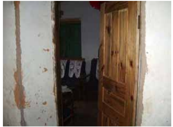
隊員居室予定の出入口扉
