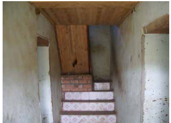
2階に通じる階段 左側が隊員の居室予定の出入口、右台所出入口
