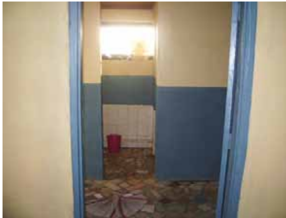
トイレ・シャワー室 出入口扉は錠前無しの板扉 高窓には鉄格子を取り付けている。
