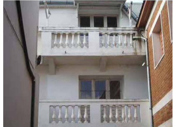
左同 2階テラスの扉は鉄格子付きであるが、3階の扉は鉄格子を取り付けていない。
