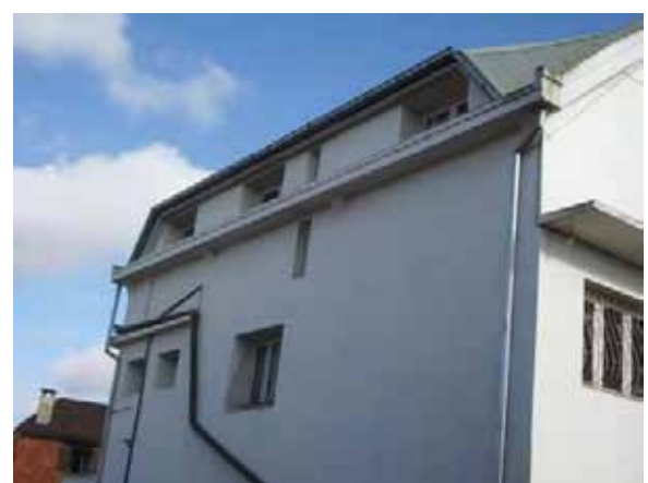
高窓部分にも接近できる。
