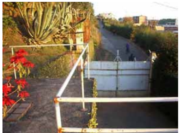
裏門と塀 門の扉の左側は植え込と有刺鉄線の塀で敷地内へ侵入可能である。
