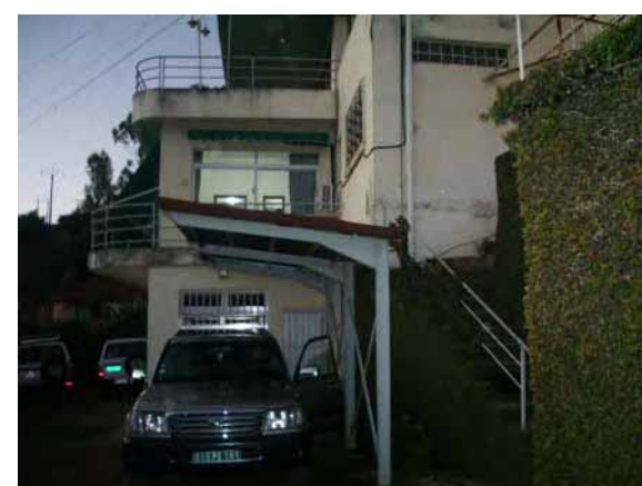
所長室の窓と車庫の屋根 階段から屋根に上り所長室の窓のあるテラスに侵入できる。
