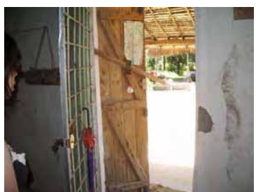
裏口(板に隙間あり破壊可能)
