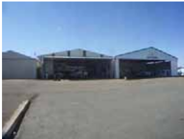
アンタナナリボの格納庫
