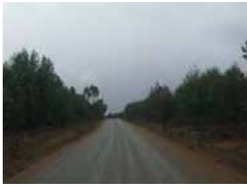
改修された国道 44 号線 盛土して固めただけ
