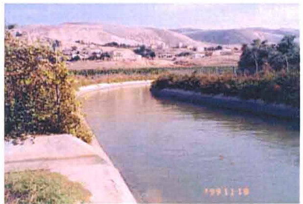
モニタリングステーション No.4 予定地 (キングアブドラ運河ワジアラブダム・ポンプ場付近)
