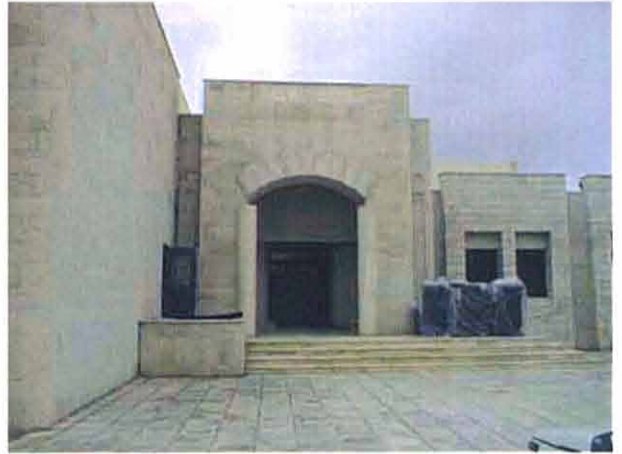
ジョルダン水公社 (WAJ) 試験所新設建屋 本計画で調査予定の化学分析機器が設置される。
