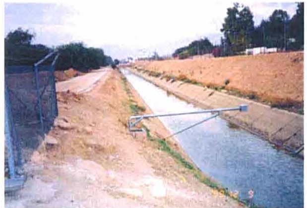
モニタリングステーション No.6 予定地 (キングアブドラ運河ザルカ川合流点)
