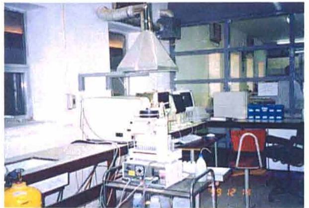
ジョルダン溪谷開発公社 (JVA) 試験所内部 本計画で調査予定の化学分析機器が設置される。
