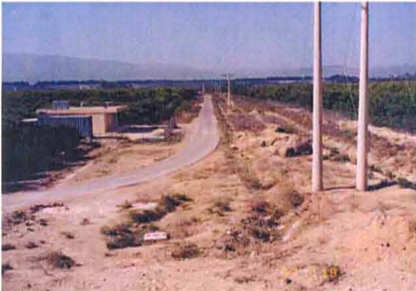
モニタリングステーション No.3 予定地 (キングアブドラ運河タイベリアス導水管路合流点)
