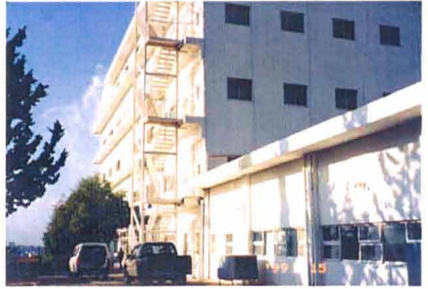
モニタリング・センターが設置される予定の王立科学院 (RSS) 管理棟
