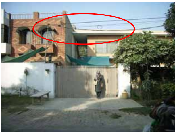
隊員住居通用門前 隣家と繋がっており、屋上から屋根に侵入可能
