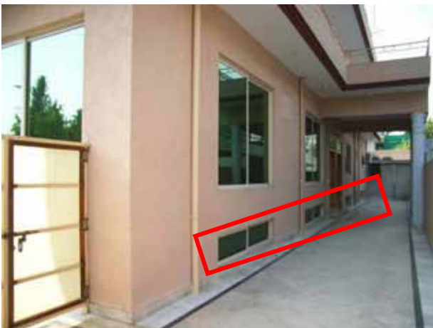
隊員住居の窓 四角部分が地下の窓
