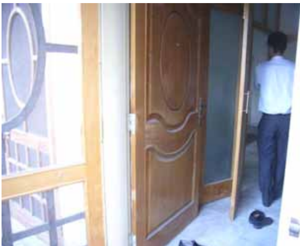
隊員玄関扉 外側の扉は金網
