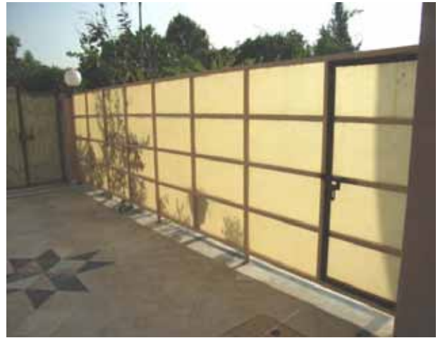
大家宅庭との仕切り 扉に施錠をしており大家側からしか開けない
