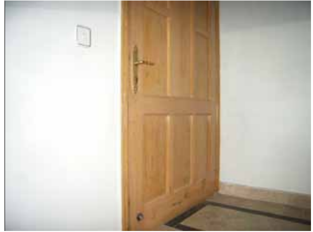
大家宅出入口扉
