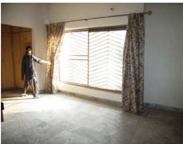
ゲストルームの窓 内側に鉄格子を取り付けている。 他の部屋も同様
