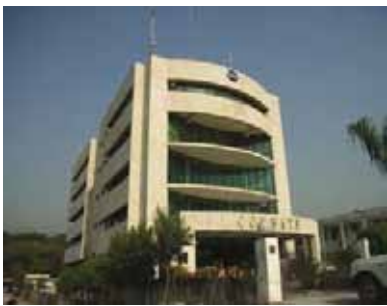
JICA パキスタン事務所入居ビル
