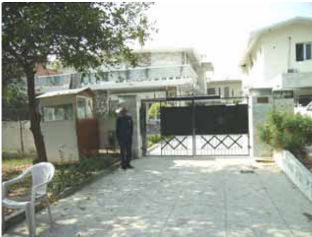
連絡所と正面通用門
