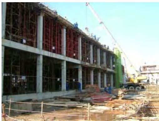
建設中のワクチン製造施設（3）
