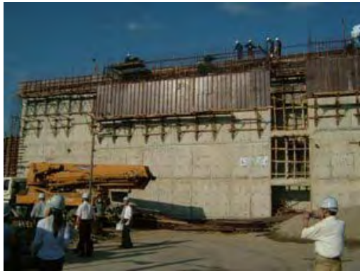
建設中のワクチン製造施設（1）
