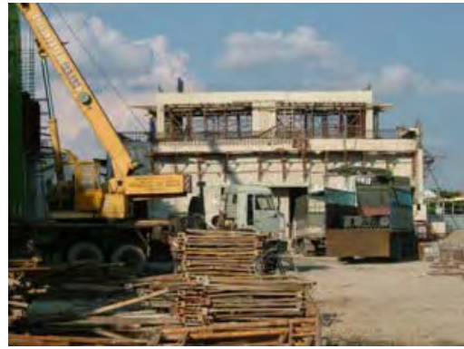
建設中のワクチン製造施設（2）
