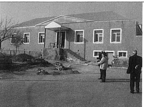
写真47：ハンラルの新築中のZVL。ハンラルのDVSもこの中に入る
