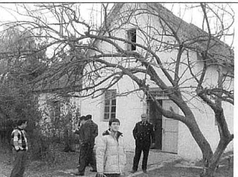
写真55：同事務所の倉庫。1953年に建造され、診断ラボとして使われていた
