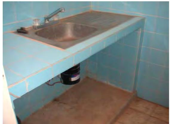
写真12：2007年度に要請されている胎盤処理器。一般的にディスプレイといわれているもので、胎盤を破碎して下水に流している。（本文 p. 23）
