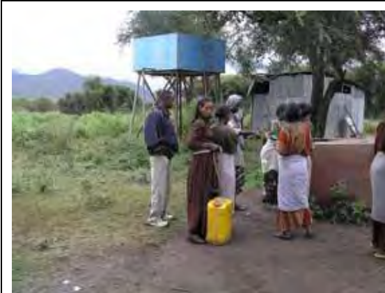
写真-5：オンスポット施設（井戸、配水池、発電機室がコンパクトにまとまった施設）
