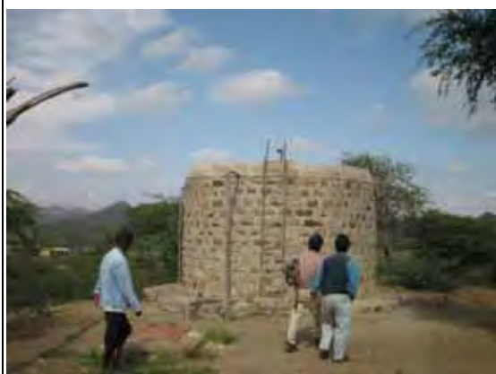
写真-4：鉄筋コンクリートと石積ブロックによるサンドイッチ構造の配水池
