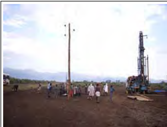
写真-7: ヒルカ集落の試掘ボアホールと商用電力施設
