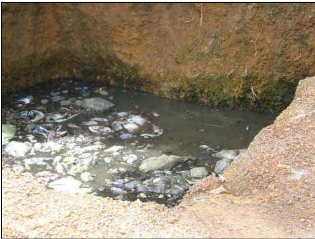
クリヤピティヤ町衛生埋立処分場候補地 (既存処分場) し尿投棄状況
