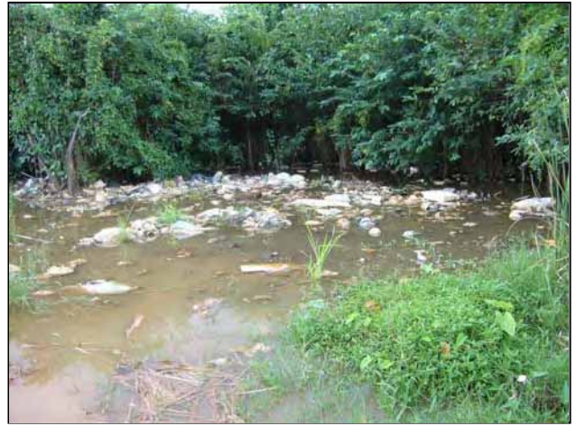
アンバランゴダ町衛生埋立処分場候補地 (既存処分場) 水の滞留によりごみが浮遊
