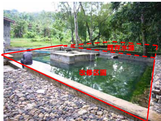
写真-9. ADB プロジェクトで改修 (水の浸出を防ぐために鋼矢板打設) された Auki の Kwaibala 湧水水源
