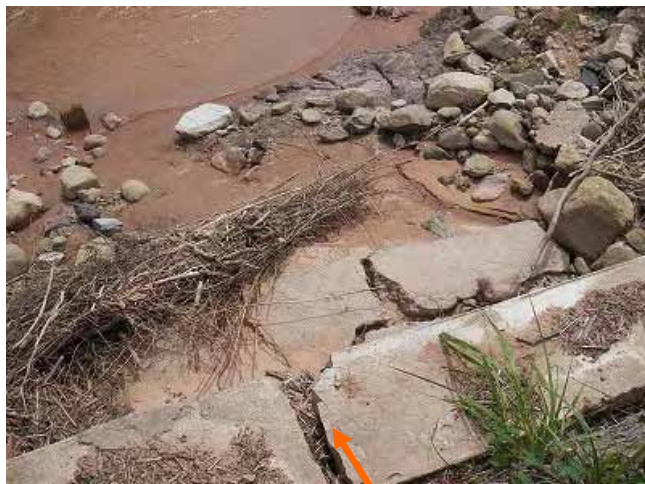
Foto 9.7.14 Abertura del muro de contención por la compresión lateral
