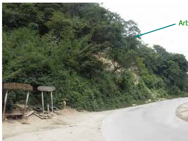
Foto 9.7.7 Señalización vial para Villa Melina
