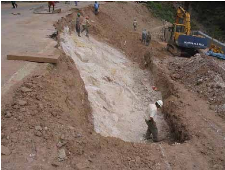
Foto 9.11.2 Roca base para la cimentación del suelo reforzado (La coronación de la cimentación a 2,0m más abajo del obrero sobre la línea blanca)
