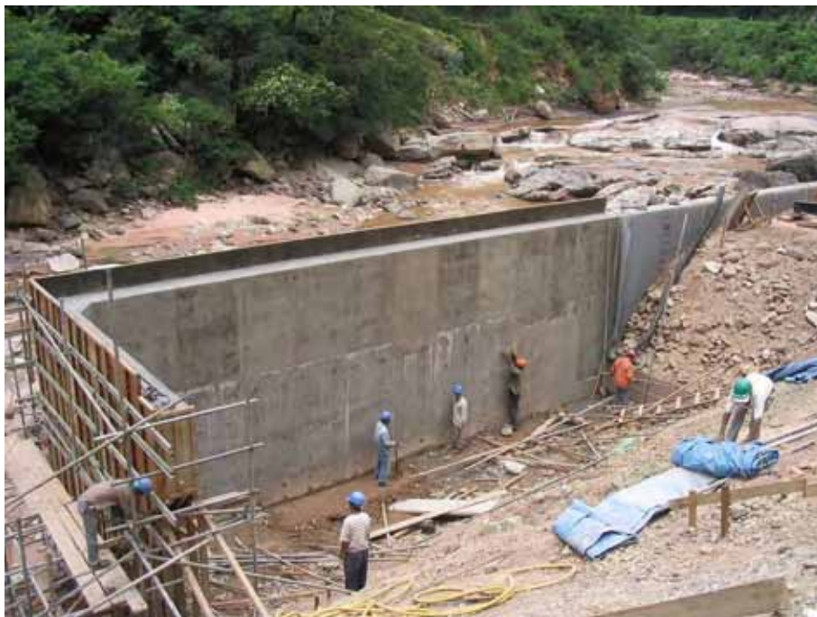
Foto 9.13.7 Protección de orilla (Muro de contención en T inversa en ejecución)
