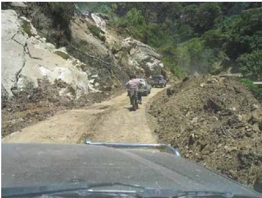
Foto 9.13.5 Caída de rocas
