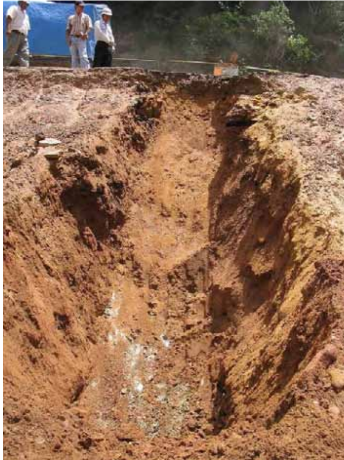
Foto 9.11.3 Suelo inestable debido a mala ejecución de obra (Excavable con una operación de pala mecánica)
