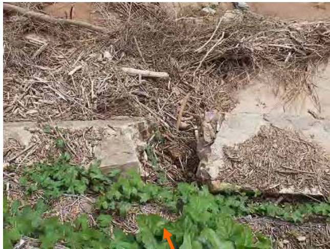
Foto 9.7.13 Abertura el muro de contención por la compresión lateral
