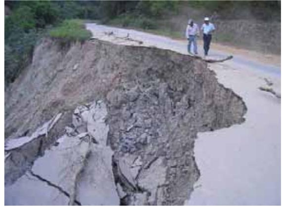
Derrumbe de Carreteras Causado por la Lluvia
