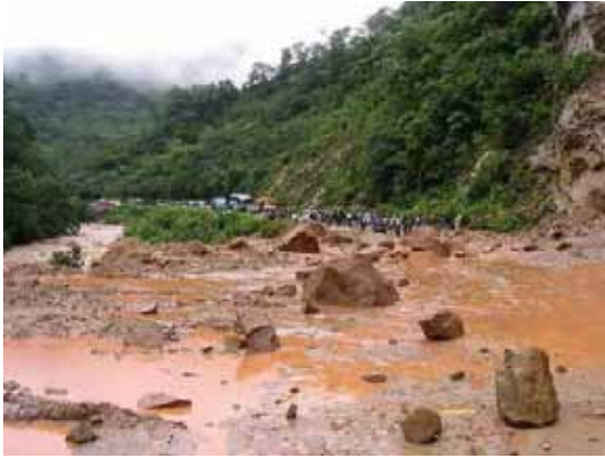
斜面崩壊による泥と落石 国道7号線ベルメホ地区(2007年2月)
