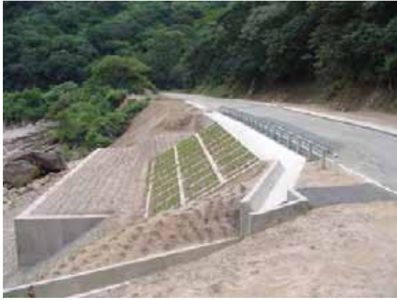
パイロット工事完成 (2007年3月)
