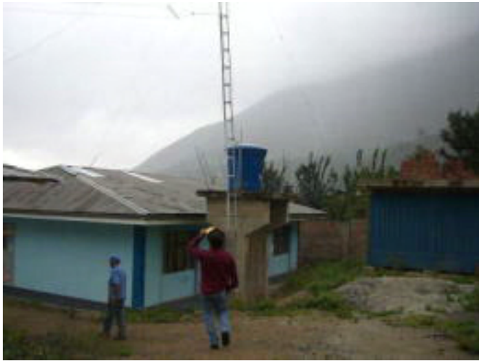
飲料水の簡易備蓄塔。
