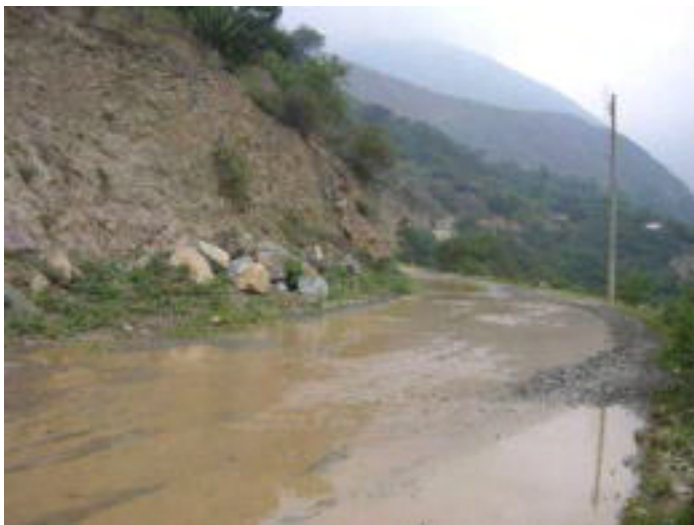
雨季には降雨に伴い、落石と冠水が頻発する。
