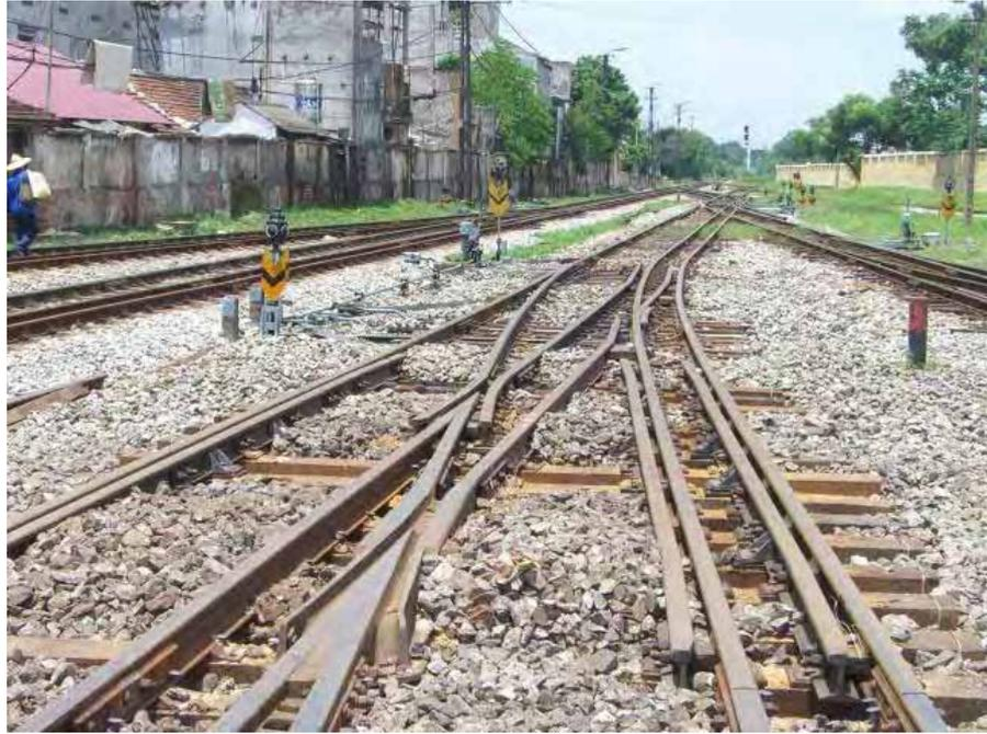
写真 2 - 2 イエンビエン駅構内の三線分岐器
