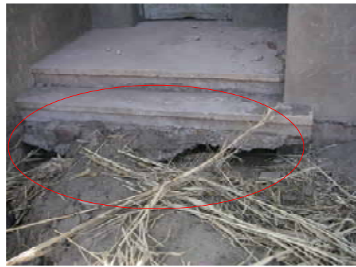
写真-12：右岸既設建屋では床下の基礎処理が不十分ため、床下に空隙を生じている。
