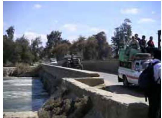
写真-10：既設橋通行状況。100年前に建設された併設橋に、農業用トラック、運搬用ピックアップトラック、乗用車等、多種にわたる車輦や重量車輦が通行しており、併設橋の安全性が懸念される。
