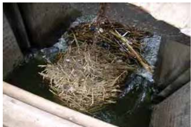
写真-6：ゲート門内の塵芥物の堆積状況。ゲート吊チェーンに塵芥物が雪だるま式に絡み付いており、腐敗臭の発生や水質汚濁を生じている。
