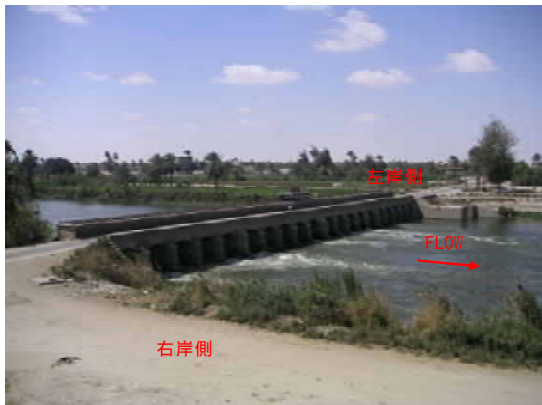
写真-1：既設ダハブ堰の全景。水面が白く泡立っている箇所は、ゲートから放流を行っている箇所である。ゲート門数が20門と非常に多いが、開閉機が1台のため操作が煩雑かつ非効率である。
