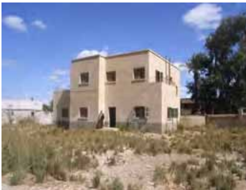
写真-11：ダハブ堰右岸側の既存建屋全景。
