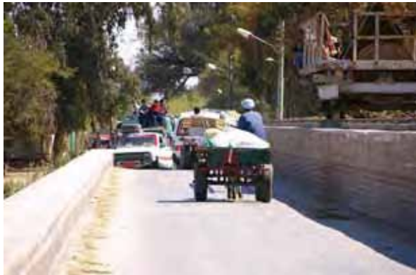
写真-9：併設橋通行状況。併設橋の幅員が狭いため、併設橋端部ですれ違いを行う必要があり、円滑交通や流通の支障となっている。
