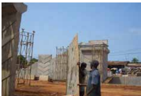
歩道橋工事(中国コントラクター)
