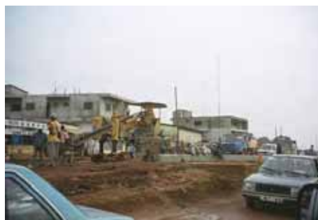
コンクリート打設作業(中国コントラクター)
