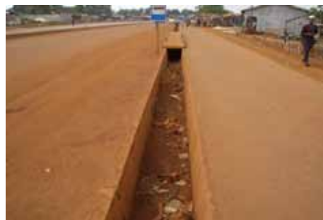
道路側溝の状況(Voie Express)
