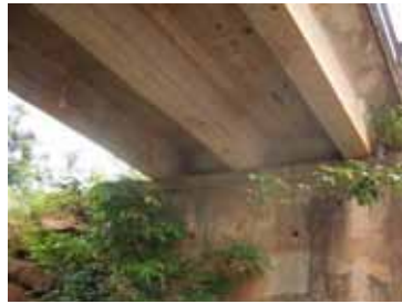
主桁の状況(特に損傷はない)
