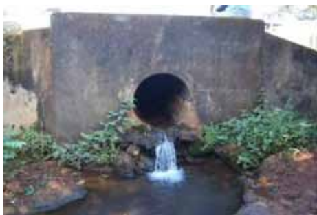
排水施設(5.0km 付近)
