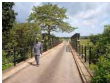
道路始点側より橋梁を臨む
