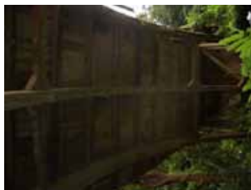
コンクリート主桁
