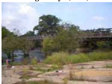
橋梁全景(Bailey 橋)
