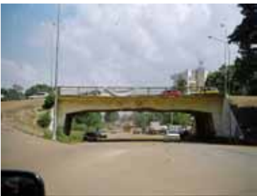
RN1 橋梁 コナクリ RN1 橋梁
