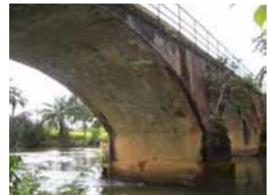
橋梁アーチ部
