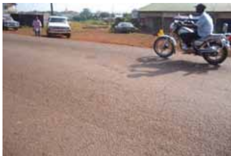
現況舗装状況(4.1km 付近)
