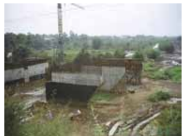
RN1 建設中の橋梁(Enta-Dabompa)
