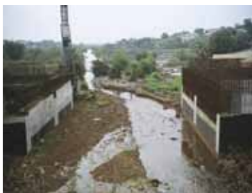
RN1 建設中の橋梁(Enta-Dabompa)
