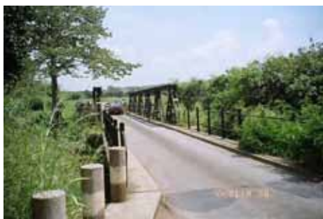
ボトルネックになっている橋梁
