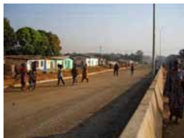
工事中区間(Lot5 アラブファンド)
