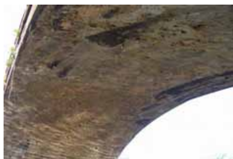
アーチ下面の状況
