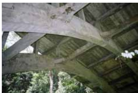
アーチ主桁部
