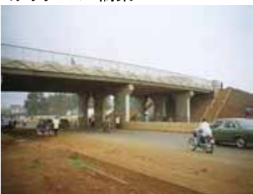
床版橋(RN1 空港付近)
