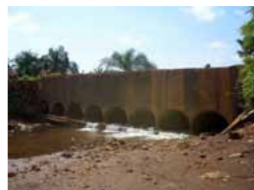
Km34.0 河川構造物
