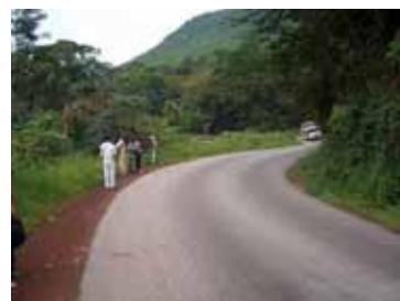
道路終点側より橋梁を臨む
