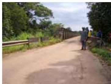
ボトルネックとなっている橋梁
