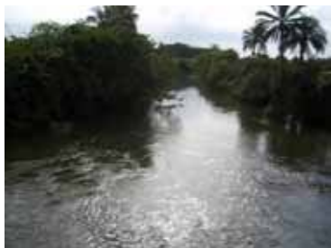
河川状況(Khoulete 川) No.6 Bridge Fanye (RN4)
