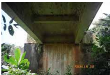
アプローチ部分と橋台の状態
