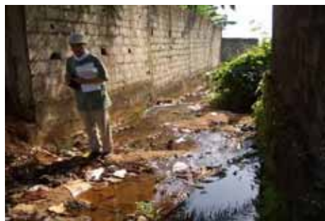
下流排水施設(5.0km)
