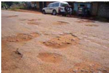
舗装状況(5.3km 付近)
