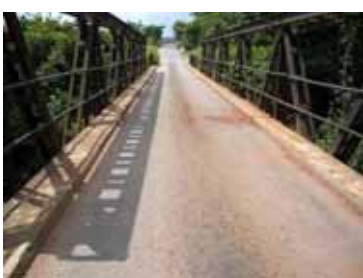
ボトルネックとなっている橋梁
