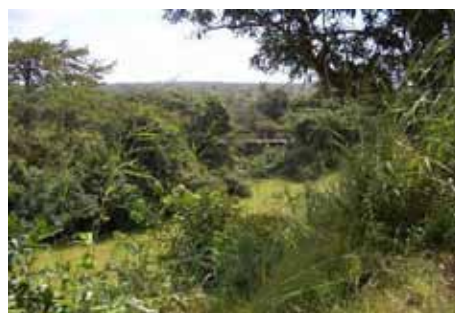
河川上流より橋梁を臨む
