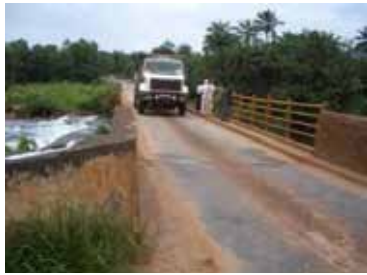
ボトルネックとなっている橋梁 No.4 Bridge Dandaya (RN4)
