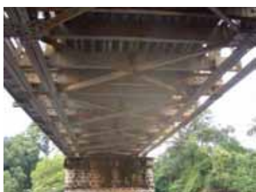
橋梁状況(特に損傷はない)
