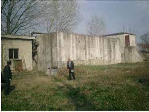
他方、Dracevo処理場（左写真参照）は、処理場施設は機器類の老朽化、破損などのため使用不能のまま放置され、汚泥乾燥床も撤去されており、現在流入汚水全量はポンプ場でスクリーン後、直接河川などへ排除している。
