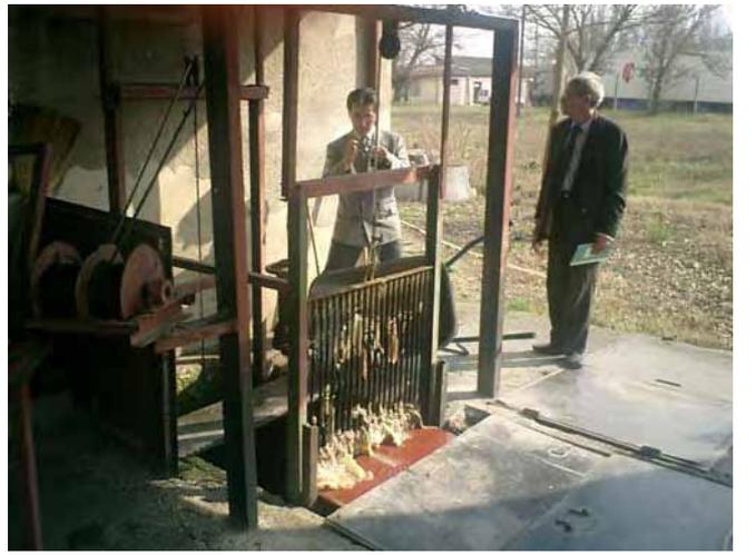
写真-10 流入ポンプ場手動スクリーン掻揚装置
