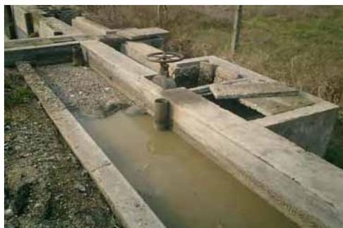
Lisice処理場ではImhoff槽1系列に送水し(左写真参照)、沈殿処理後、近隣の水路へ放流を行い、汚泥は月に2回程度重力で汚泥乾燥床に排出し、乾燥汚泥は埋立てあるいは近隣の農家などに提供してきた。残りのImhoff槽1系列は利用されずそのまま放置され、沈殿後の塩素滅菌は行わず、そのまま河川へ放流している。
