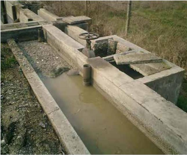
写真-7 Imhoff Tank 流出口
