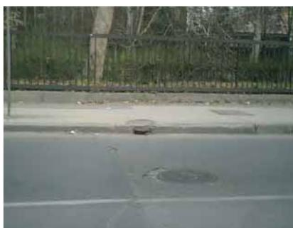
現在、すべての収集汚水は家庭から汚水管網、幹線を通して直接あるいはポンプ場からVardar川へ放流している。路面雨水は、道路側溝に30～50m程度の間隔で設置した雨水枡（写真参照）で収集し雨水管に接続し雨水幹線からVardar川へ直接あるいはポンプ場から排除する。汚水、雨水をVardar川に排除している吐き口は市内に49カ所（PHARE報告書）あり、汚水の全量は未処理のままVardar川に流出している。一方、雨水は市街地にある排水枡から排水管に流下し河川へ排出されるが、過去に市
