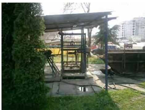
左の写真は、ポンプ場流入口の手掻き細目スクリーン装置で適時に人力で掻き上げ、ポンプ室に流下し放流先水位の状況に応じて、越流若しくはポンプ作動により排水する。
