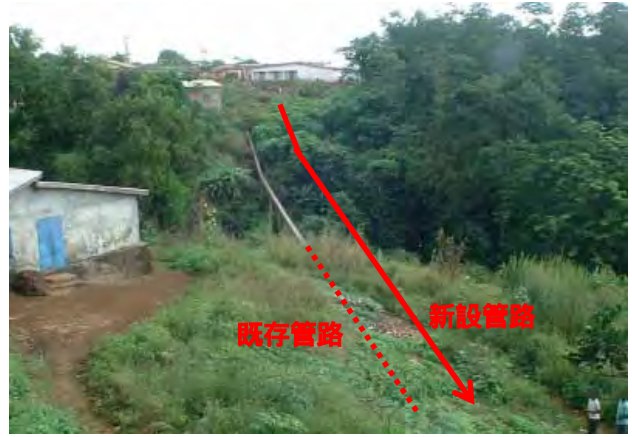
新設送水管路は既存管路と平行して建設
