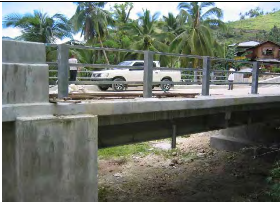
橋梁新設 (鋼桁、英国による供与)
