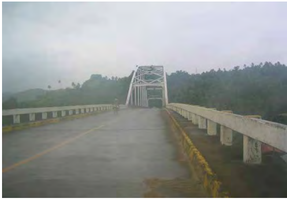
レイテ島南端の Rarion 橋全景
