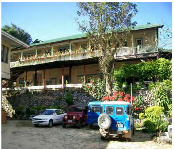
CAR 事務所管内のディストリクト・エンジニアリング事務所
