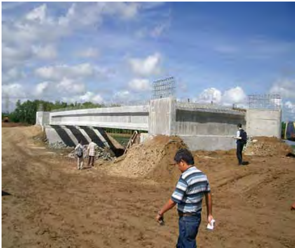
リージョンXI事務所管内での橋梁建設事業
