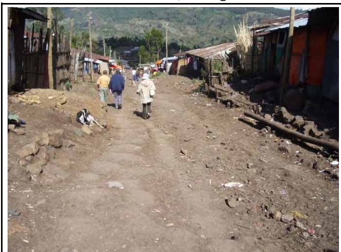
写真5：学校へのアクセス道路。農村中心部にもかかわらず、雨季には通行不可能になってしまう
