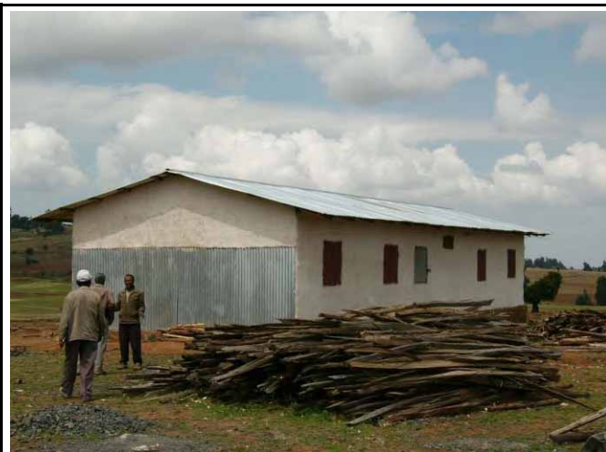
写真 1 7 : 雨掛防止の波型亜鉛鋼板を妻側に張った校舎
