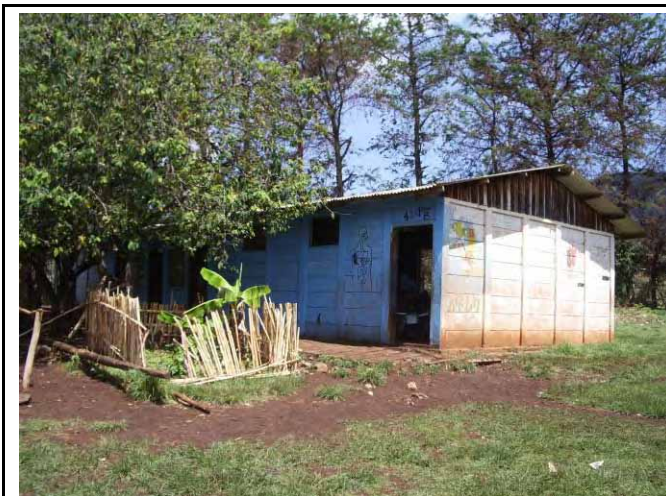
写真 23 : 1975年にCIDAの資金で建設されたプレキャストコンクリートの校舎 (Sabaallee, Kuni Wareda, Herarge West Zone)
