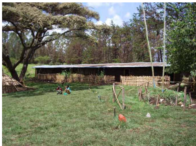
写真7：コミュニティが建設した土壁校舎
