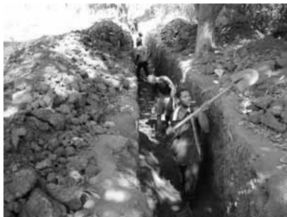
Vue du déblai en terrain rocheux
