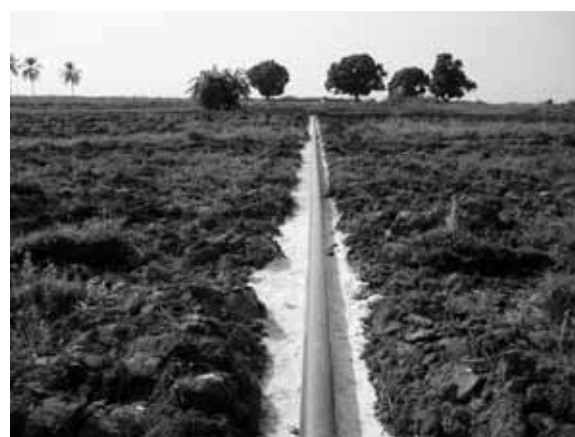
Vues des lits de sable et la pose des tuyaux PVC
