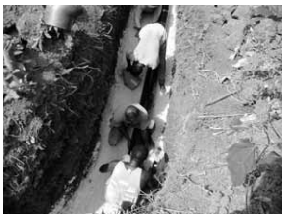
Vues des lits de sable et la pose des tuyaux PVC
