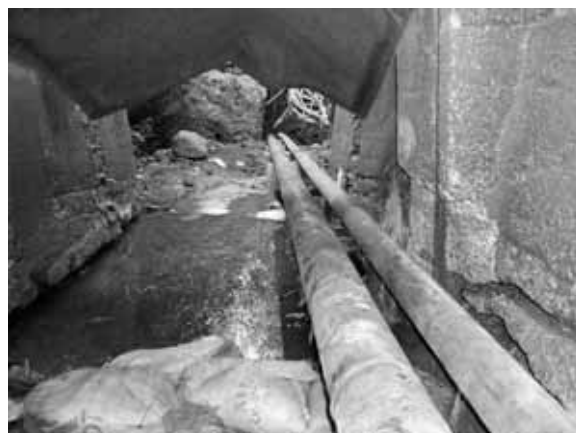
Vue de la pose des tuyaux en acier
