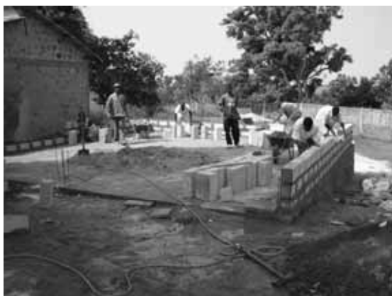
Hangar en construction
