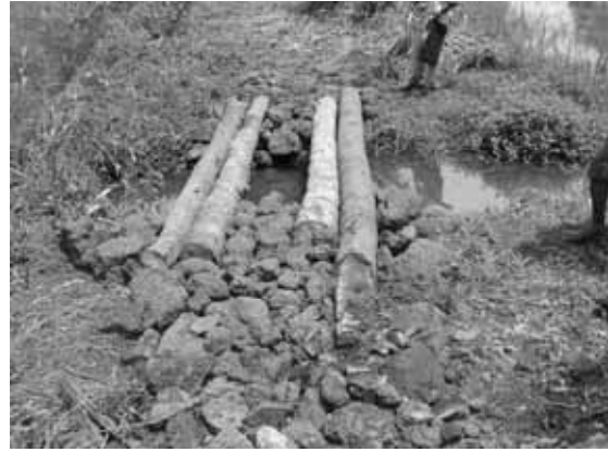
Pont en bois construit
