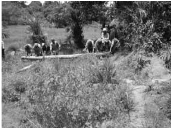
Exécution de l'amélioration des pistes d'accès agricole
