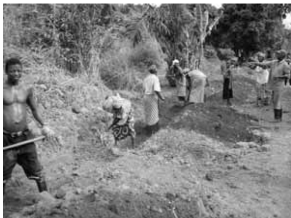
Vue du déblai en terrain meuble (avec la participation des membres)
