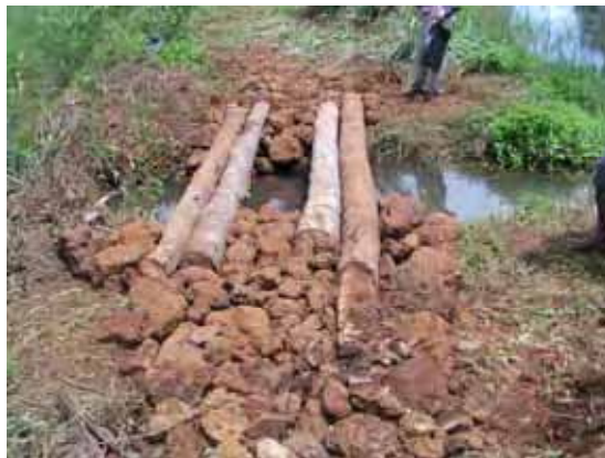
Pont en bois construit
