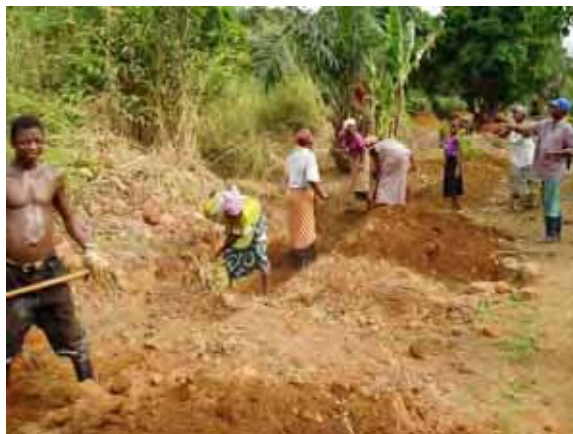
Déblai grâce à la participation et à la collaboration des membres du groupement
