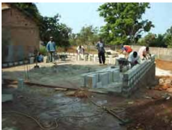
Hangar en construction
