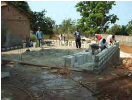
建設作業中の倉庫
