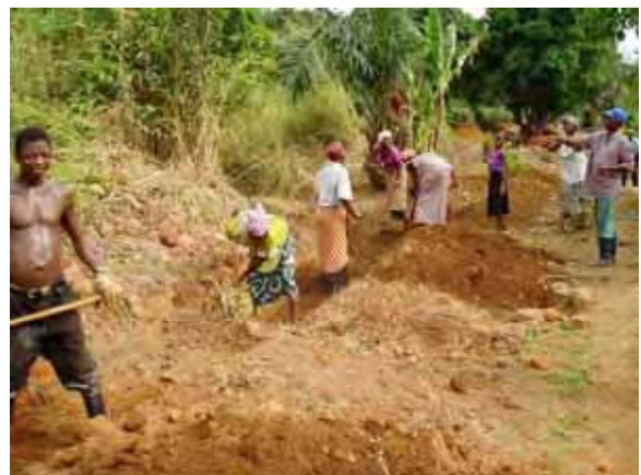
普通土掘削状況 (農民グループピロットの参加による)
