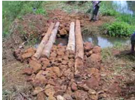
建設された木橋
