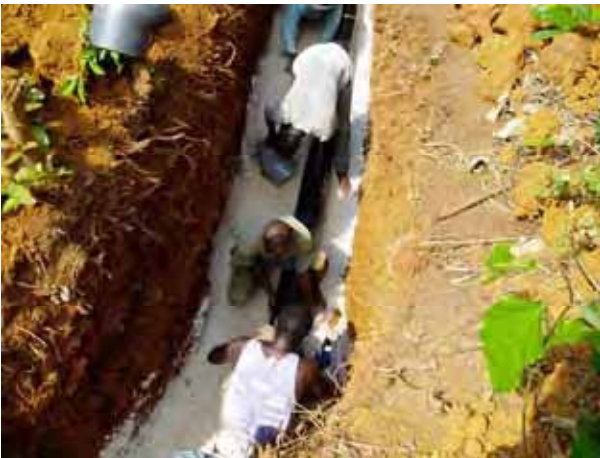
小規模灌漑パイプライン設置
