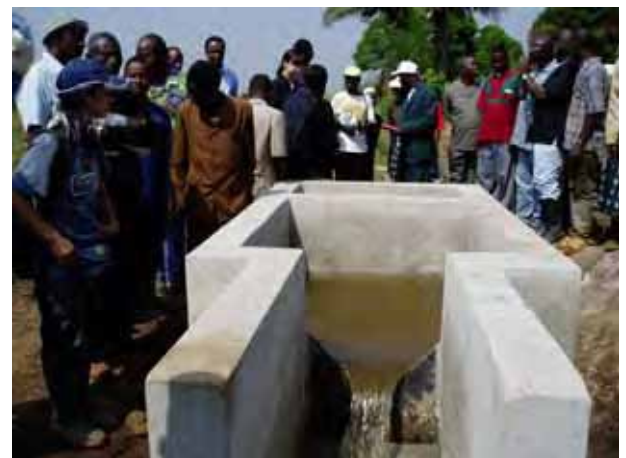
小規模灌漑量水計付き吐水槽
