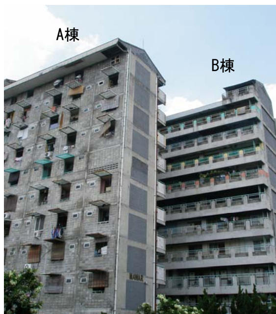
パサール・ジュマツ実験住宅
