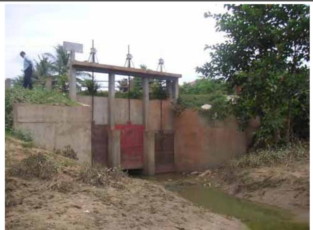
プルスット市街地に位置する Prey Nhy Irrigation System の取水工 上記取水工の上流側の状況を示す。ゲートは鋼製ゲートに更新されており、プルスット川の水位が上昇する洪水時には取水が可能である。
