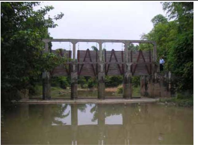
プルスット流域の最東部に位置する Coh Chhom の取水堰 ゲートは木製であり、フックに吊り下げて開閉を行う。プルスット川から Nhy Irrigation System の灌漑水路を經由して灌漑水が供給可能である。
