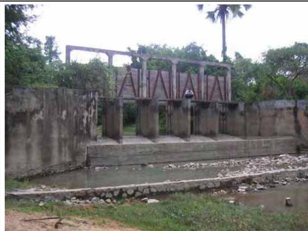
プルスット流域の最東部に位置する Coh Chhom の取水堰 上記取水堰の下流部 侵食等による被害は発生していない。
