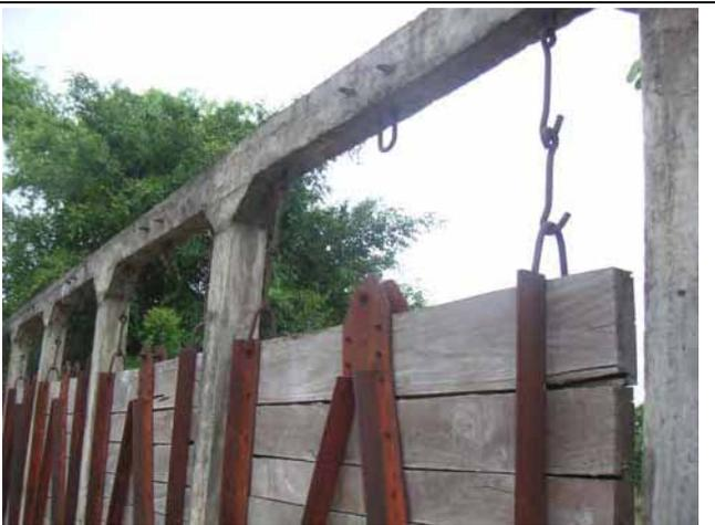
プルスット流域の最東部に位置する Coh Chhom の取水堰 堰上げゲート部 写真にあるフックにより開閉が行われる。
