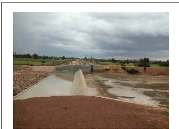
写真 4-5 オロカ灌漑システムの取水堰
