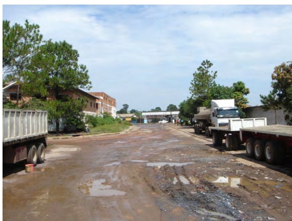
K2: ユークリッド道路 大型車両による道路破壊
