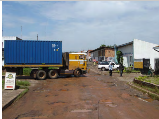
K3 ゾンバ道路 大型車両とポットホールによる破損
