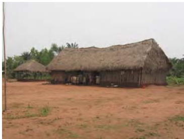
仮設木造教室
