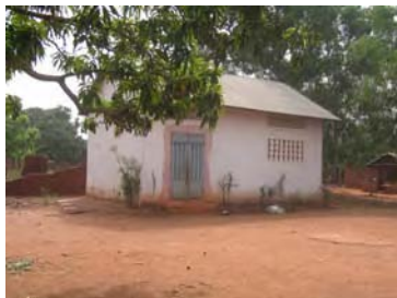
既存食料倉庫
