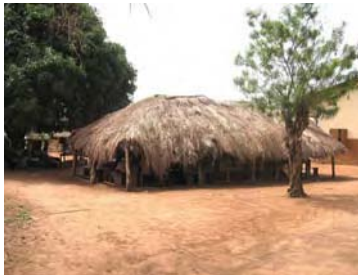
仮設木造教室
