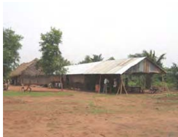
仮設木造教室（金属屋根葺）
