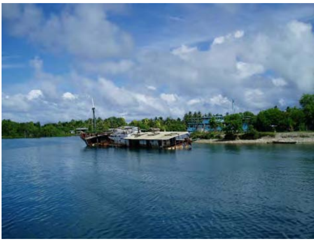
写真-6：既存棧橋北側の新棧橋建設サイトを既存棧橋より望む。
