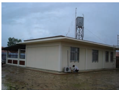
2. 敷地背面(側面)
