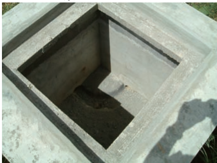
d. 敷地内排水点検枡
