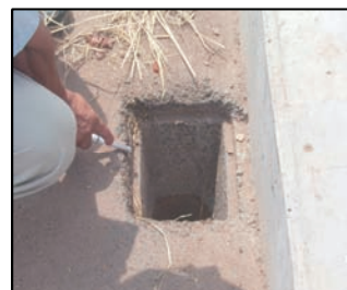
橋面排水ののみ口
