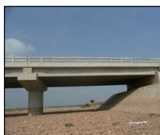
A1橋台、P1橋脚側面全景
