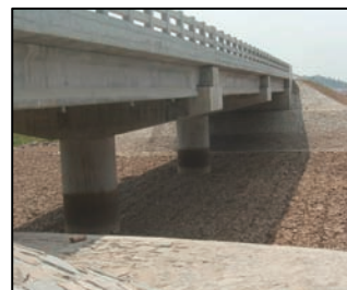
橋梁側面全景
