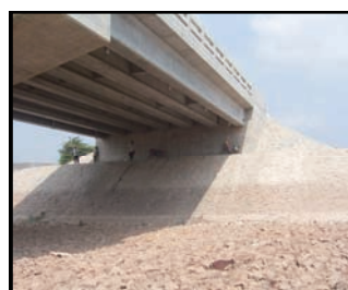
A1橋台と護岸工
