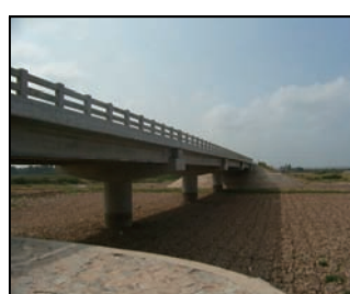
橋梁側面全景
