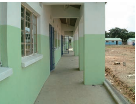
b. 教室棟屋外廊下
