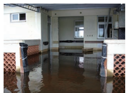
3. 待合ホール 冠水の様子
