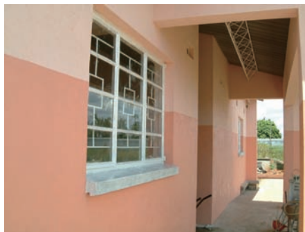
b. 管理棟屋外廊下
