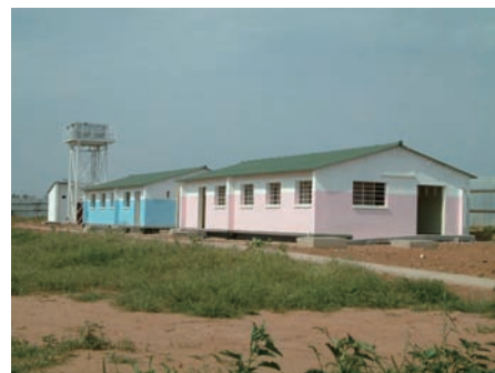
c. 便所棟と高架水槽・ポンプ小屋
