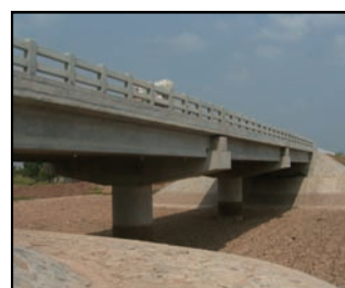
A2橋台と護岸工
