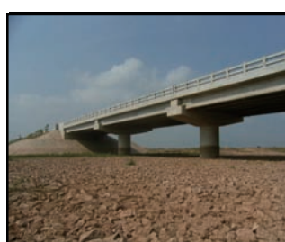
P2, P3橋脚とA2橋台側面
