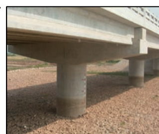
P1橋脚側面
