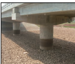
P1, P2橋脚
