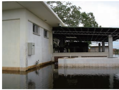
2. 外観(正面) 冠水の様子
