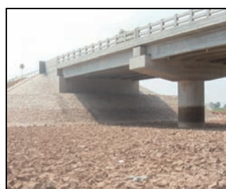
橋梁側面と高欄工
