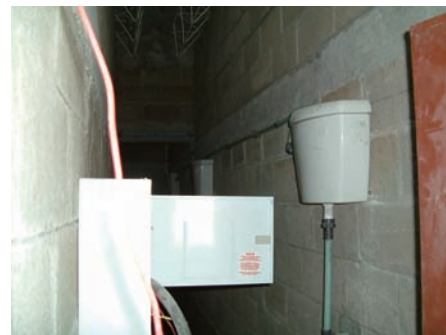
c. 便所棟サービスダクト
