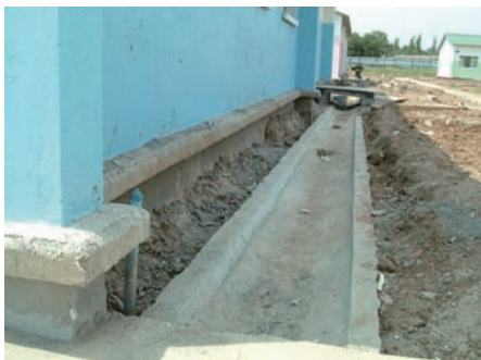
d. 基礎立上がり部と排水側溝
