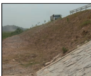
A2橋台側盛土工
