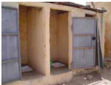
Construction de toilettes (École Guéoul I, Kébémér)
