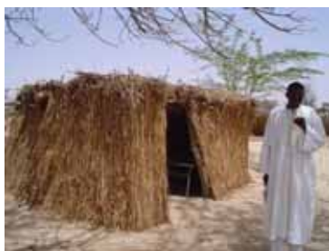
Construction de classes en abris provisoires (École Thiakhao Gaye, Kébémér)
